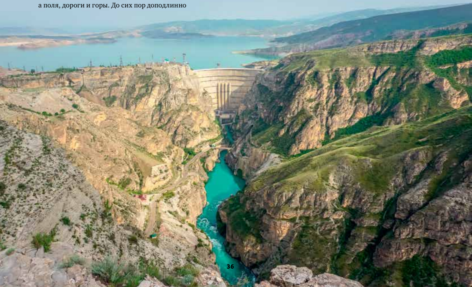
Вид на Чиркейскую ГЭС с высоты птичьего полета
